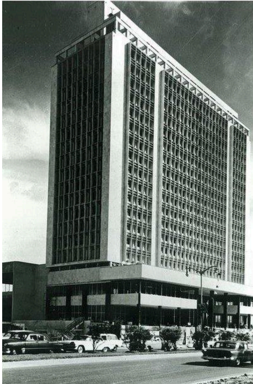
Edificio de Instituto Nacional de la Reforma Agraria, en La Habana. (Foto: CMA Architects & Engineers LLC)
